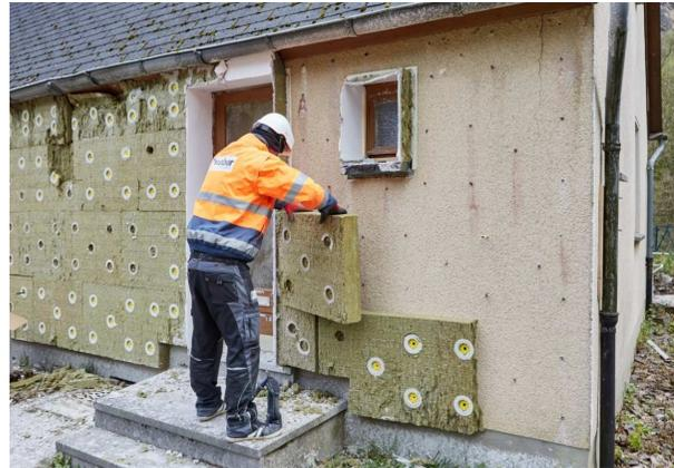
Fonte: Saint-Gobain Weber: Recyclingfähiges Wärmedämmverbundsystem, in Detail selection: Recycling: Materialien, Systeme, Konzepte, 2020.
