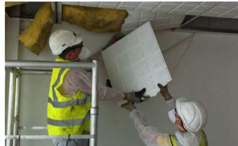
Stri-out: rimozione lastre controsoffitto contenente amianto.
