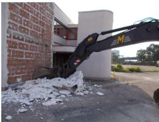
Fig. 4, Rimozione isolamento esterno di facciata con metodo parzialmente selettivo.
