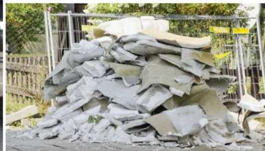
Fig. 5, Isolamento esterno di facciata rimosso con metodo parzialmente selettivo.
